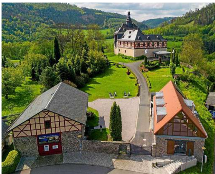
Blick auf die Schlossanlage Eichicht nahe Saalfeld. Rechts unten ist das auf dem Grundriss einer Feldscheune errichtete Mehrzweckgebäude mit Wildmetzgerei, Hofladen und Jagdschule zu sehen.
